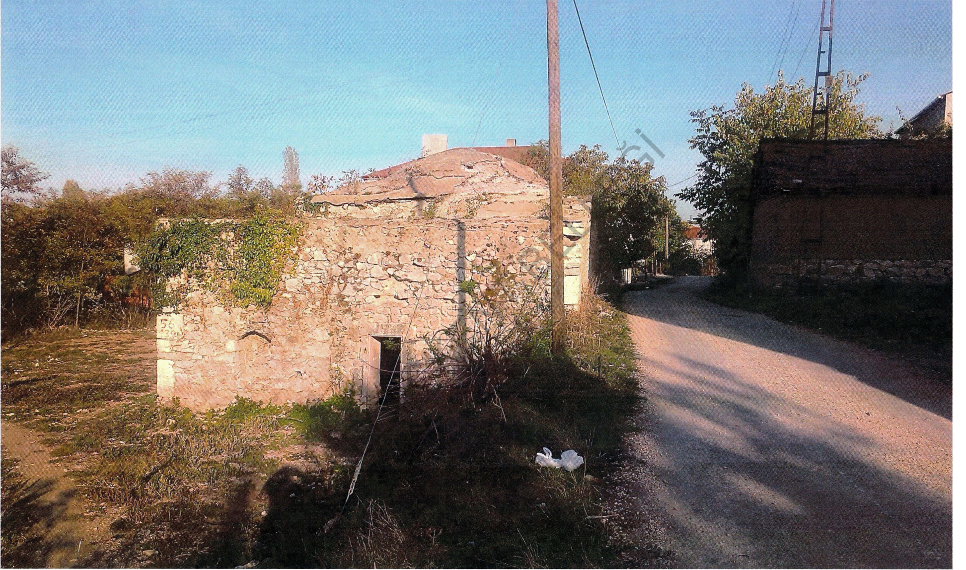
Şekil 1-pelitözü köyü hamamı-H.Dündar
