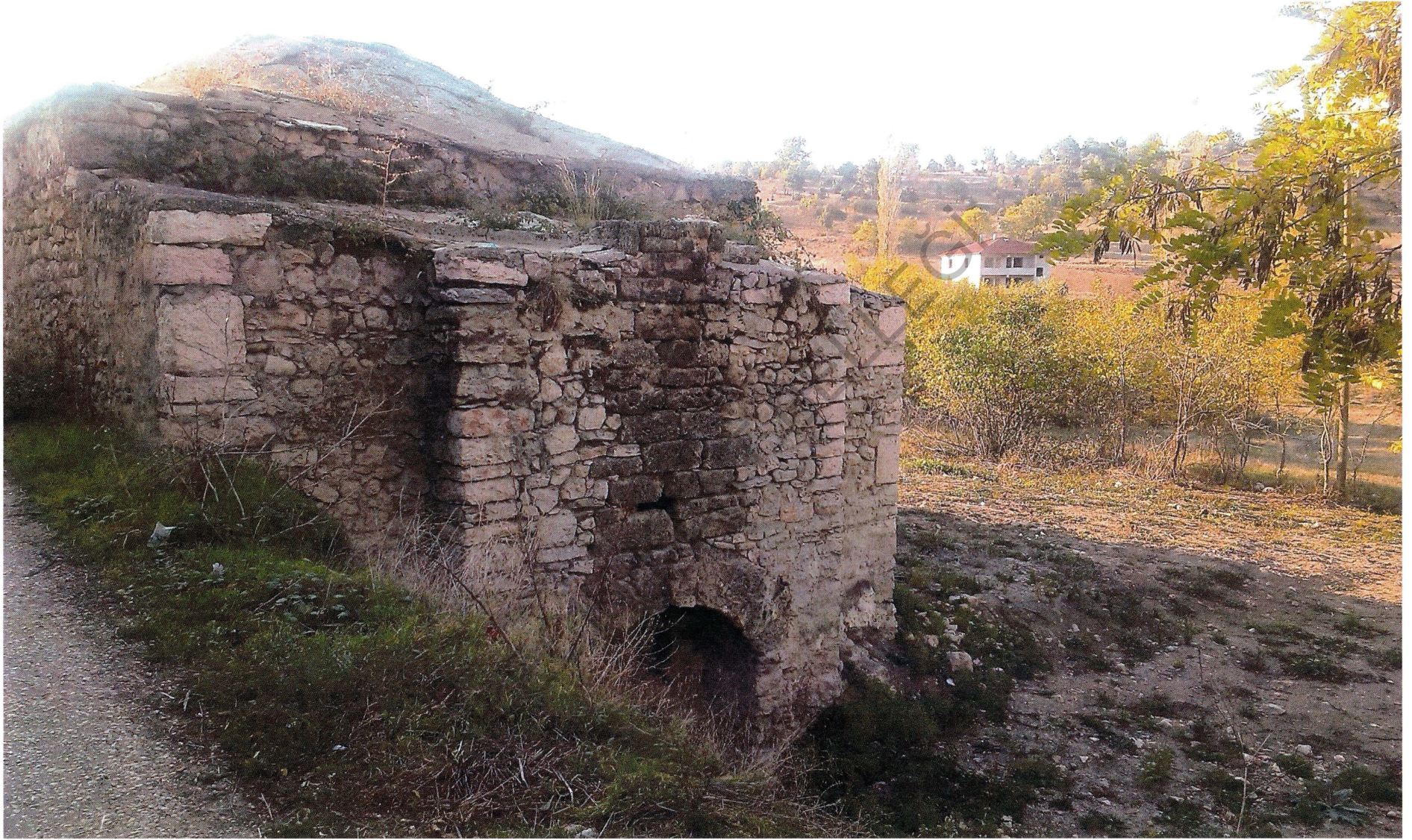
Şekil 30-Pelitözü Köyü Hamamı - H.Dündar
